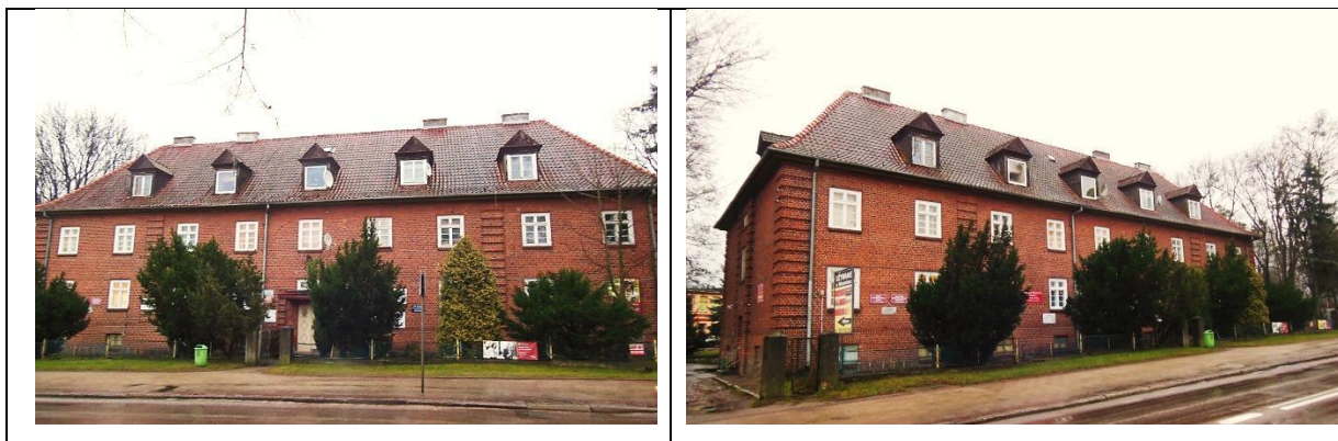
Zdjęcia: A. Michalak, budynek ul. Olsztyńska 10, stan 2018 rok
