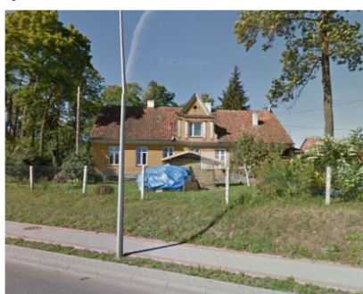
zabudowa podmiejska w Kosyniu
