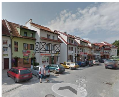
pierzeja budynków usługowo-mieszkalnych przy ul. Jana Pawła II
