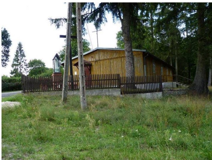
Zdjęcie. Budynek stanowiący własność Rzymsko-Katolickiej Parafii Najświętszego Zbawiciela i Wszystkich Świętych w Dobrym Mieście (działka nr 134/1).
