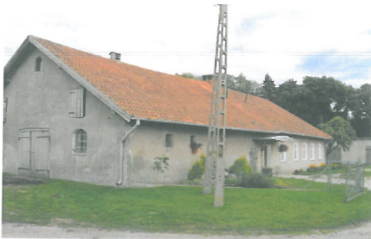
Zdjęcie 6 : budynek mieszkalny z lat 20-tych XX w.
