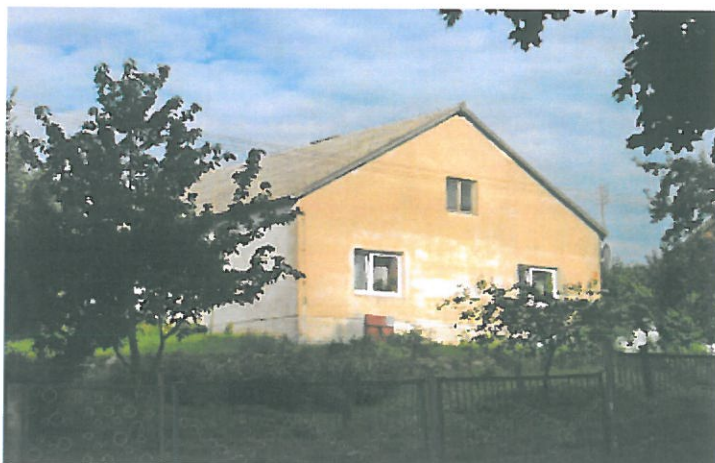
Zdjęcie 4: budynek mieszkalny z lat 20-tych XX w.
