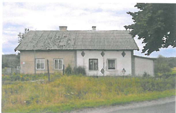
Zdjęcie 17: Budynek mieszkalny z lat 20-tych XX w.
