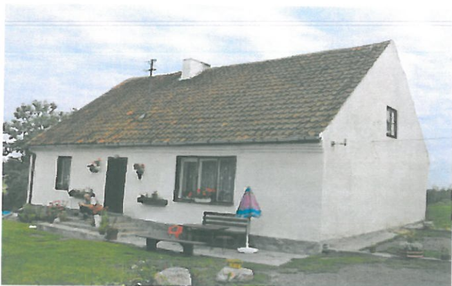
Zdjęcie 12: Budynek mieszkalny z lat 20-tych XX w.
