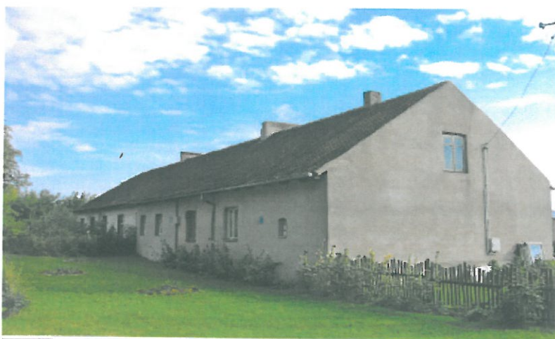
Zdjęcie 5: budynek mieszkalny z lat 20-tych XX w.
