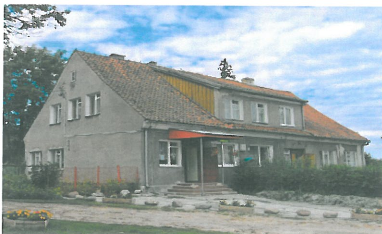
Zdjęcie 11: Budynek mieszkalny z lat 20-tych XX w.
