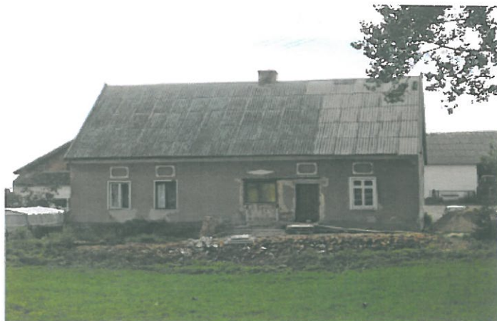
Zdjęcie 16: Budynek mieszkalny z lat 10-tych XX w.
