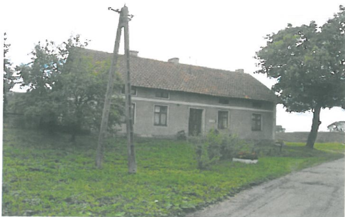
Zdjęcie 15: Budynek mieszkalny z lat 20-tych XX w.
