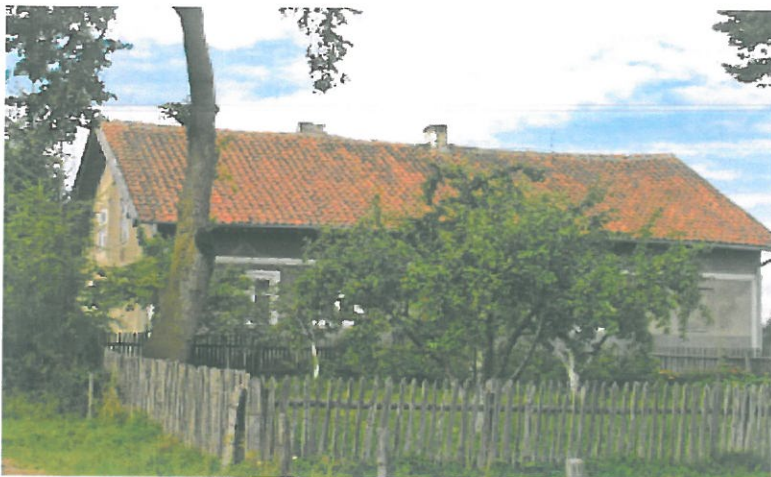
Zdjęcie 9: Budynek mieszkalny z lat 20-tych XX w.
