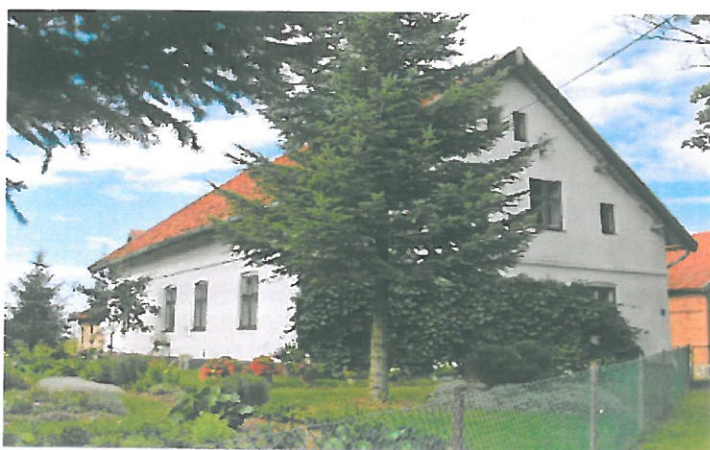
Zdjęcie 14: Budynek mieszkalny z lat 20-tych XX w.
