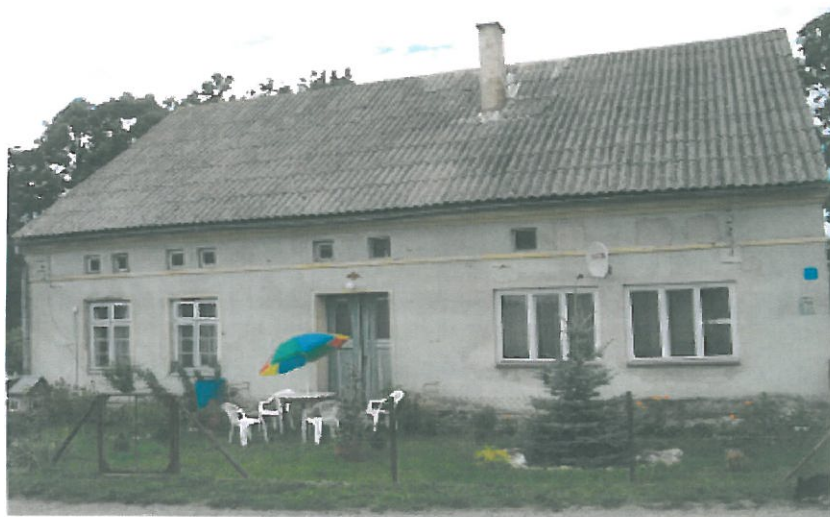
Zdjęcie 8: Budynek mieszkalny z lat 20-tych XX w.
