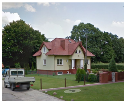
zabudowa podmiejska w Nowej Wsi Małej
