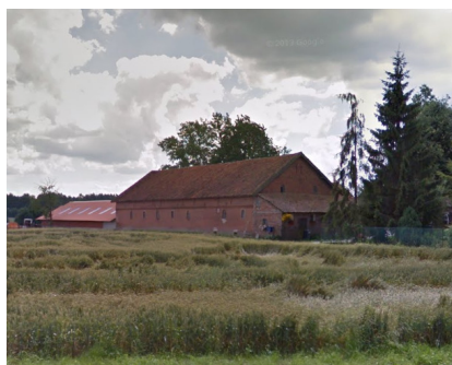
budynek inwentarski w Nowej Wsi Małej
