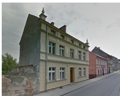
budynek wielorodzinny przy ulicy Łużyckiej
