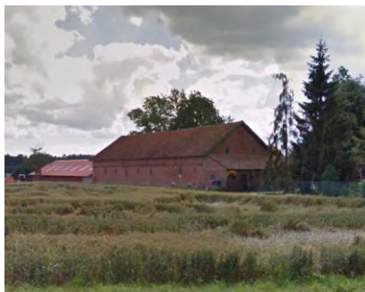
budynek inwentarski w Nowej Wsi Małej
