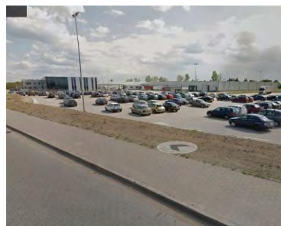
zabudowa produkcyjna i magazynowa przy ulicy Olsztyńskiej
