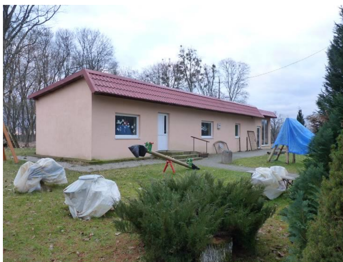
Zdjęcie. Budynek świetlicy wiejskiej w części wschodniej terenu objętego opracowaniem.
