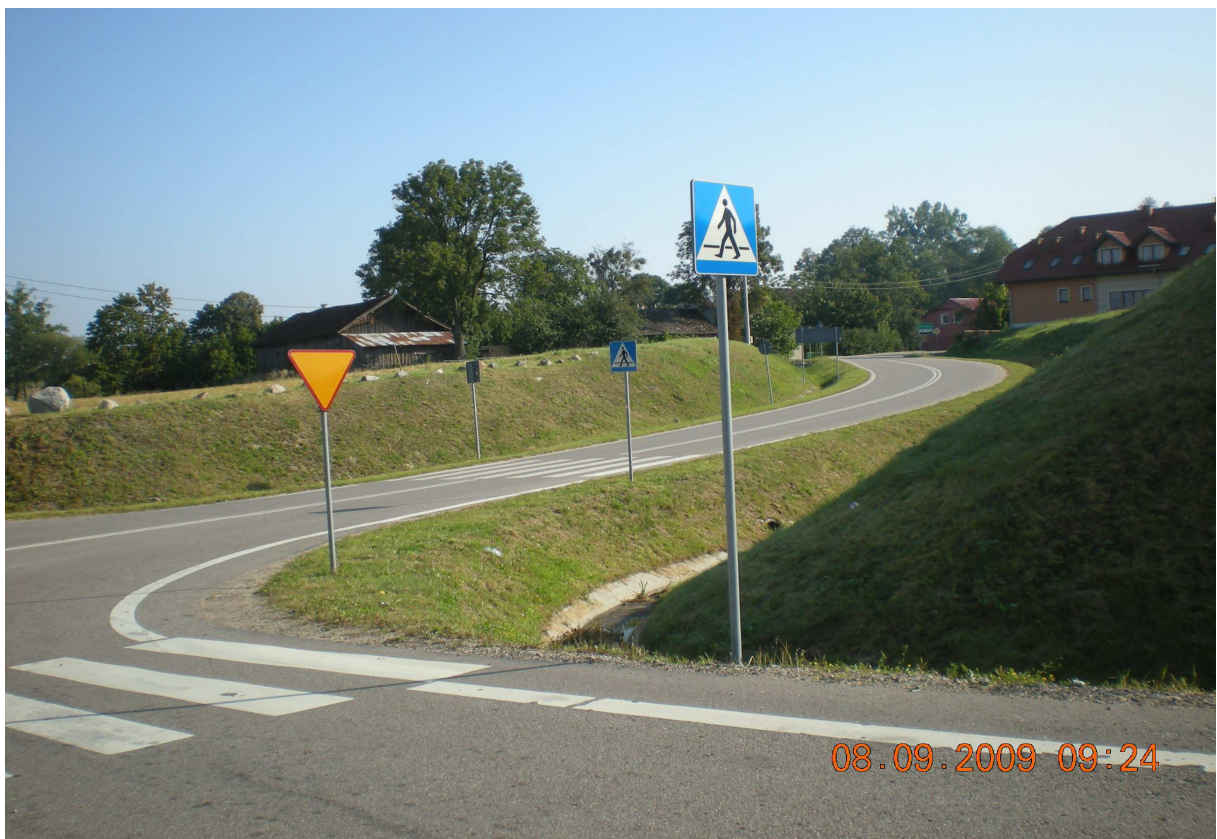
Fot. nr 2. Widok z łącznicy, z kierunku Olsztyna, w głębi wieś Barcikowo.
