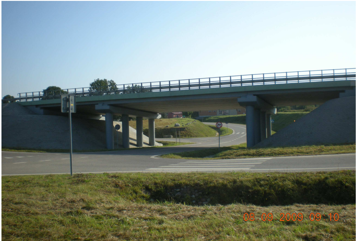
Fot. nr 1. Początek drogi gminnej, proj. chodnika),w głębi wieś Barcikowo..
